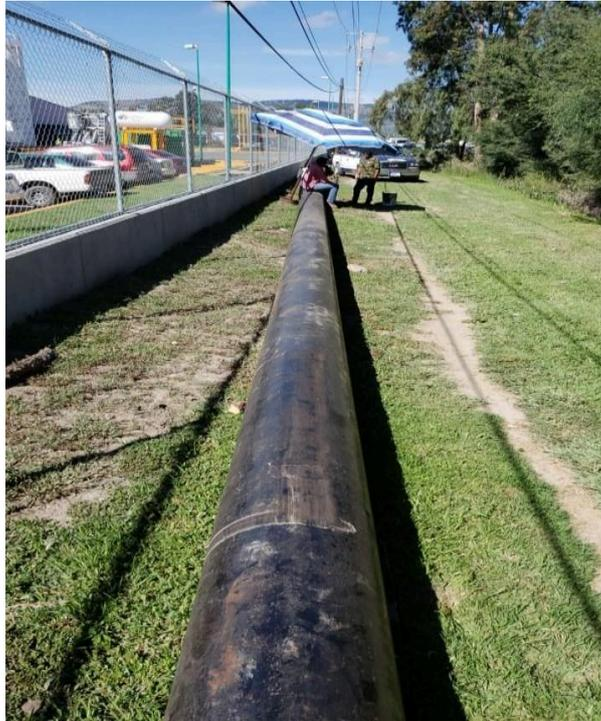
**Instalación de línea de conducción de 20" de diámetro en acero al carbón, línea de conducción de gas.**
