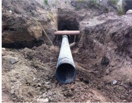
**Instalación De Tubería De Polietileno De Alta Densidad De 10" De Diámetro En La Ciudad De Querétaro, Qro** Fecha:
